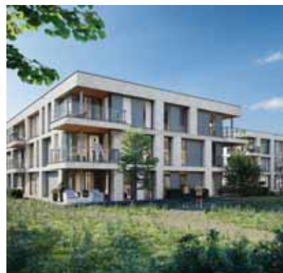
Een hoge dakrand houdt installaties uit het zicht
