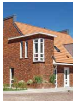
Aandacht voor de aansluiting tussen dak en gevel, met slank gedetailleerde overstekken
