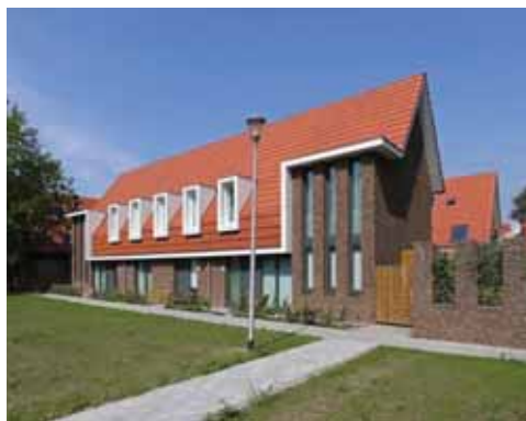
Aandacht voor de aansluiting tussen dak en gevel, met slank gedetailleerde overstekken
