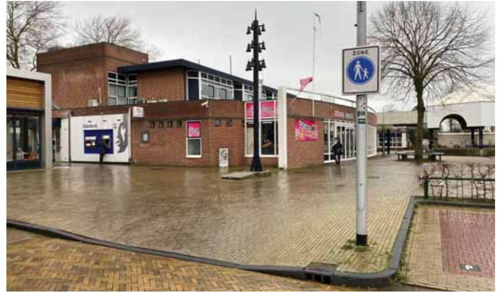
Te slopen bebouwing, (voormalig) rabobank gebouw + ijssalon Alberto
