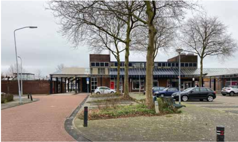
Te slopen bebouwing, (voormalig) rabobank gebouw
