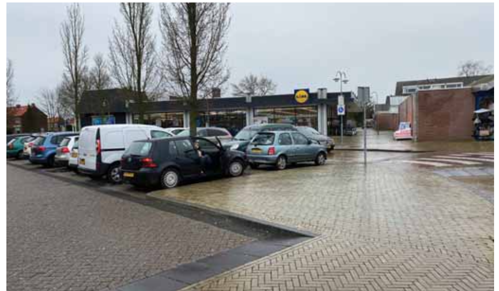
Te slopen bebouwing, huidig winkelpand Lidl
