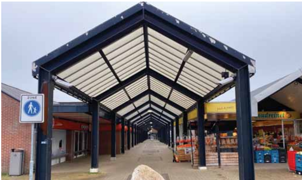
Te renoveren Meidoornpassage
