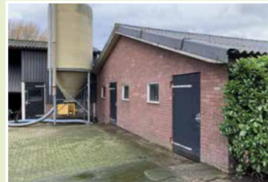
Opslag materieel, enkele struiken en installaties (D)
