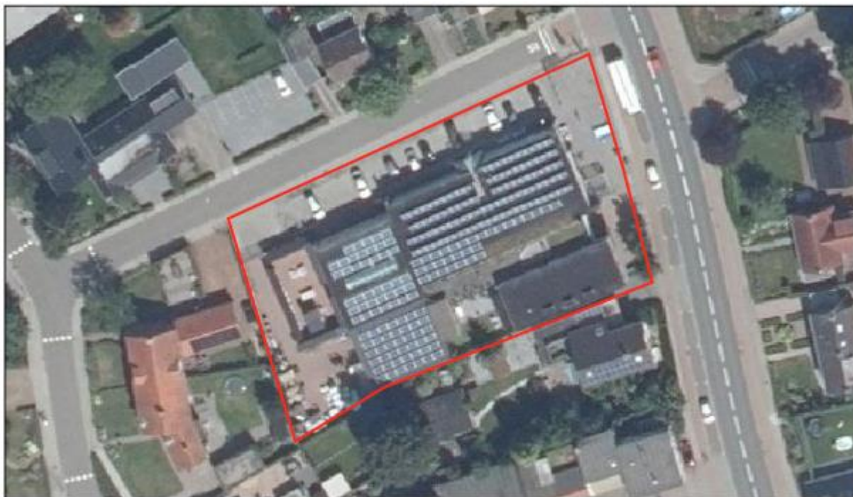
Afbeelding 2.1 Luchtfoto huidige situatie plangebied (Bron: PDOK)
