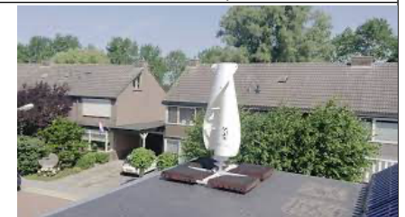
turbine met rotorbladen met verticale as.
